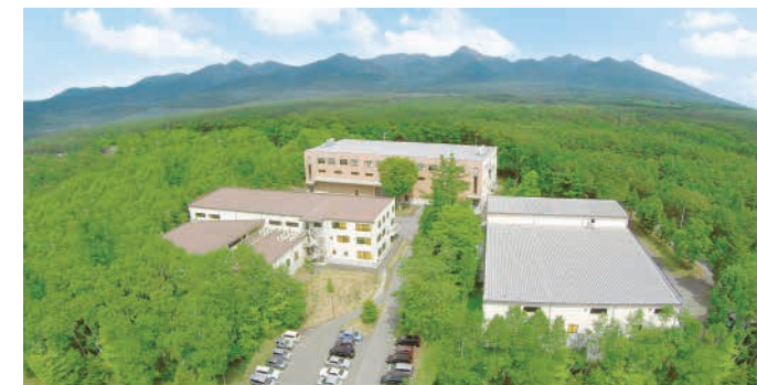
飯沼ゲージ製作所 外観
