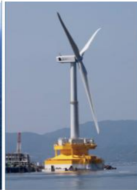
アドバンストスパー浮体 5MW ふくしま浜風
