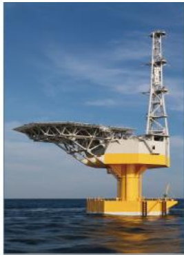
浮体サブステーション ふくしま絆
