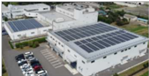
太陽光発電 (日高工場設置)
